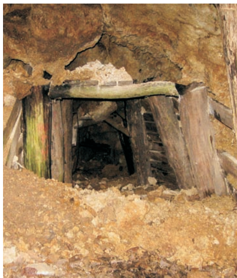
4. ábra. Az altáró első szakasza, friss földembeomlással. Fotó: Mesics G. (2013). Fig. 4. First part of the adit with recently collapsed roof. Photo: G. Mesics (2013).
